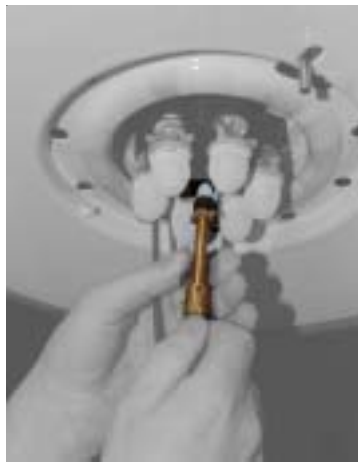
Fig. 4: Destornillar el mechero pilota
